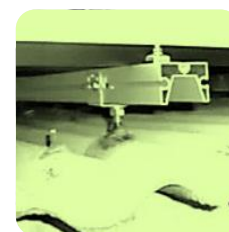
架台浮かし工法
