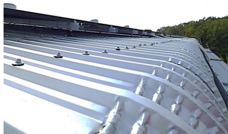
大波スレート+カバー屋根への施工例 (楽々Cチャン金具・ハサミ型)仕様
