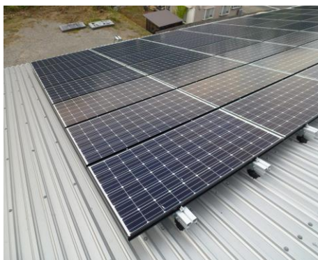
大波スレート+カバー屋根への施工例 (楽々Cチャン金具・ハサミ型)仕様
