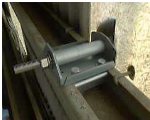
大波スレート+カバー屋根への施工例 (楽々Cチャン金具・ハサミ型)仕様
