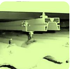
架台浮かし工法
